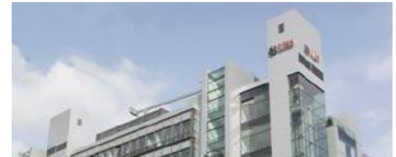
Skylight Büro- u. Verwaltungsgebäude, Frankfurt
