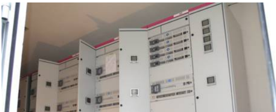
30 Rechenzentren in Deutschland
