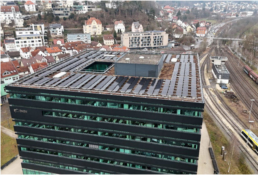
Neue Photovoltaik-Anlage auf dem Dach der Dualen Hochschule Heidenheim © Arthur Dick@Gerald Hus
